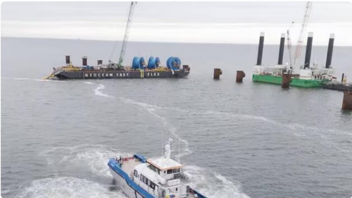
Geocean a utilisé l'un de ses concepts d'aménagement modulaire de barges pour le projet de connexion à la côte du FSRU associant Engie à TES à Wilhelmshaven (Allemagne). | GEOCEAN
